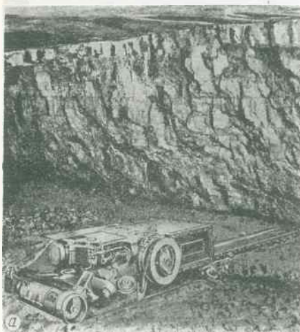
Rys. 256. Wrębiarka zabierkowa
