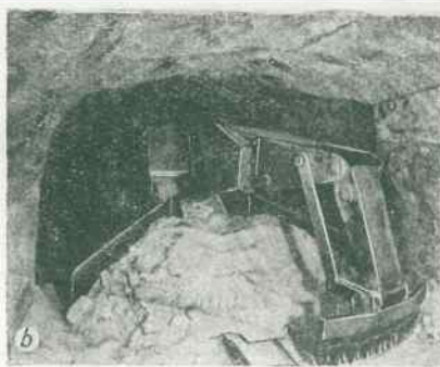
Rys. 156. Ładowarka gracowa a — wysuwanie gracy, b — nagarnianie urobku
