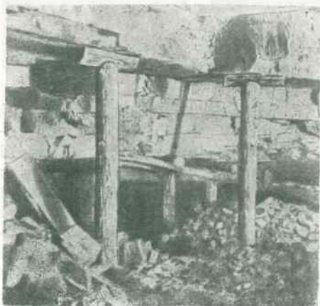
Rys. 233. Ściana obudowana krzyżami drewnianymi
