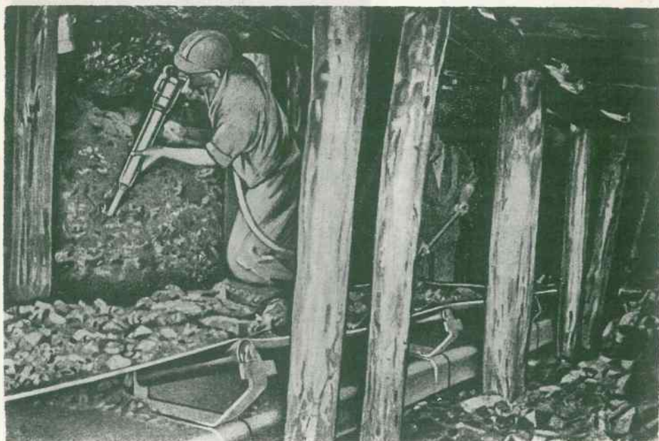
Rys. 197. Urabianie węgla młotkami pneumatycznymi w ścianie
