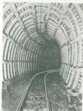
Rys. 177. Stalowa obudowa chodników łukami podatnymi
