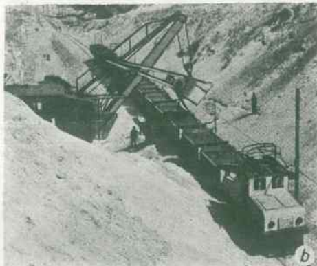
Rys. 132. Koparka nadpoziomowa w pozycji a — urabiania, b — ładowania
