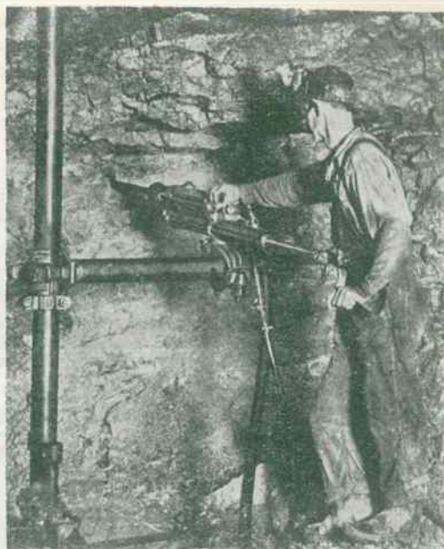
Rys. 119 (z lewej). Wiercenie otworu strzałowego wiertarką udarową z podpórki pneumatycznej
