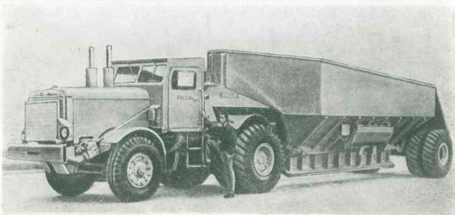
Rys. 351. Ciągnik z przyczepą 60 m 3 do przewozu urobku
