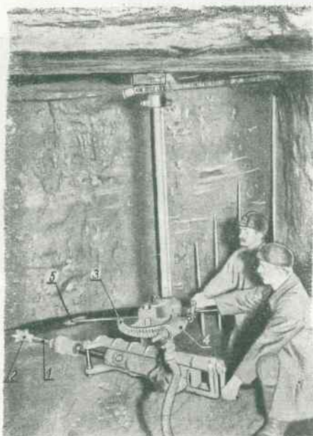
Rys. 149. Chodnikowa wrębiarka odbijająca w przodku
