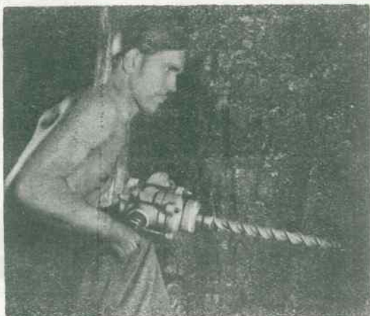
Rys. 144. Wiercenie otworu strzałowego wiertarką obrotową z ręki
