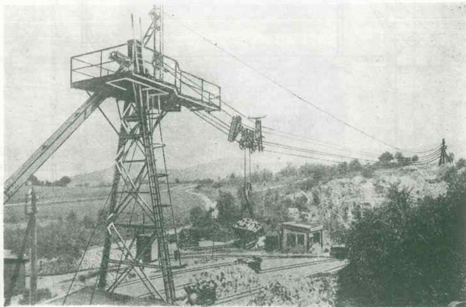
Rys. 348. Transportowanie dźwignicą wozu z urobkiem
