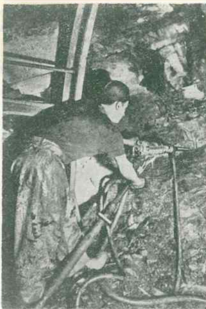
Rys. 119 (z lewej). Wiercenie otworu strzałowego wiertarką udarową z podpórki pneumatycznej
