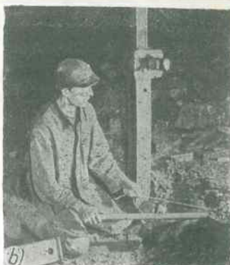
Rys. 289. Ładowanie otworu strzałowego
