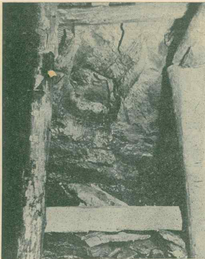
Strop słaby, łupkowy, ze skawieniałą roślinnością karbońską i otworem po wypadniętym pniu
