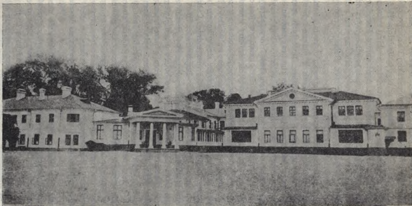
82. Antoniny — pałac Potockich od frontu w 1903 r. (po lewej oficyna tzw. sanguszkowska po nadbudowie, po prawej fragment oficyny dobudowanej przez Marię i Alfreda Potockich)
