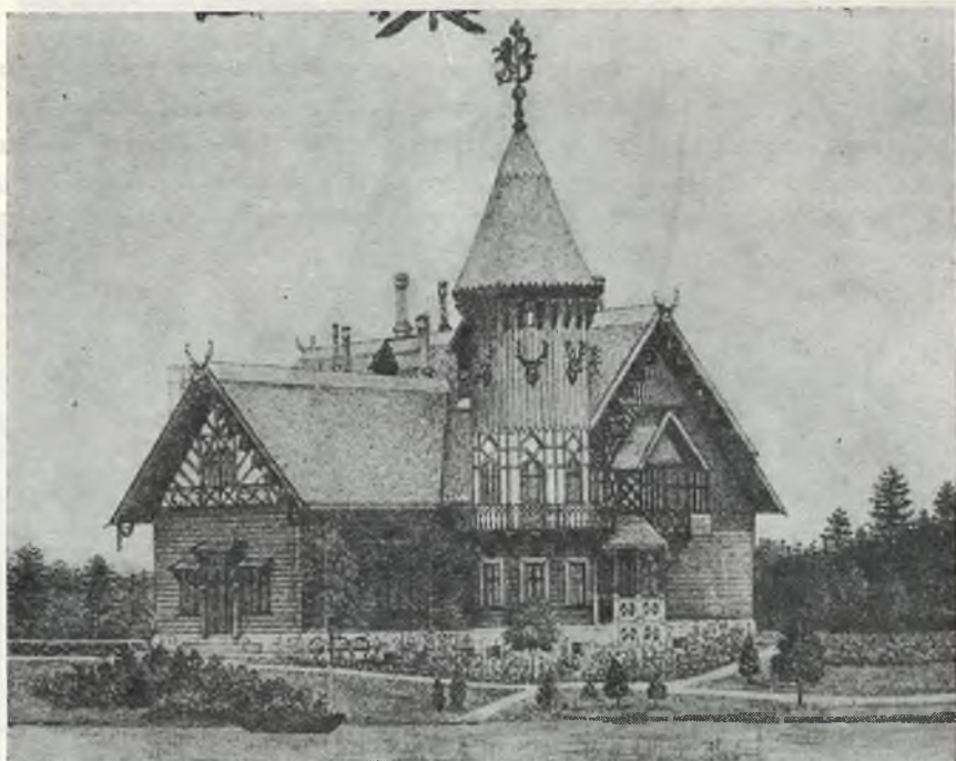
29. Zamek myśliwski Promnice. Widok od strony północno-zachodniej. Widoczne partie ścian z odsłoniętymi fragmentami muru szachulcowego. Wg litografii ręcznie kolorowanej E. Depoix'a z 1864 r. Zbiory Muzeum w Pszczynie, nr inw.
