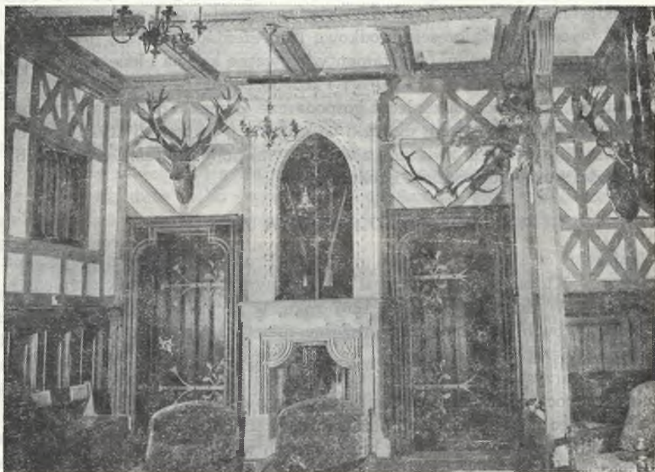
34. Zamek myśliwski Promnice. Widok na południowo-zachodnią część reprezentacyjnego hallu. Stan obecny z elementami stolarki Fryderyka Rehorsta i kominkiem wykonanym przez rzeźbiarza Plischke
