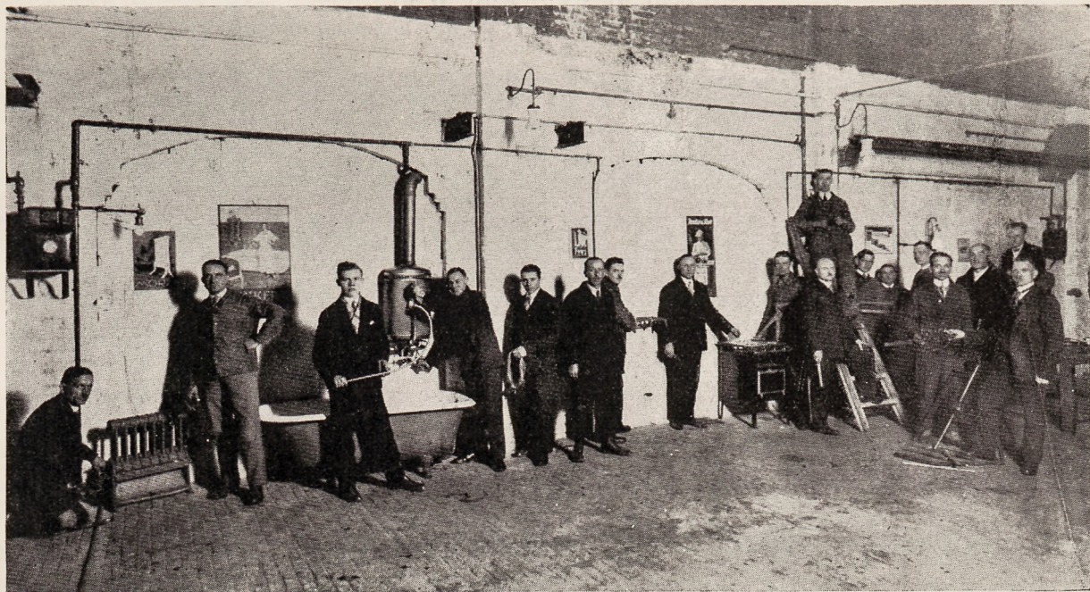
1. Kurs dla monterów instalacji gazowej i wodociągowej w Katowicach.
