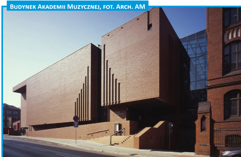
BUDYNEK AKADEMII MUZYCZNEJ, FOT. ARCH. AM
