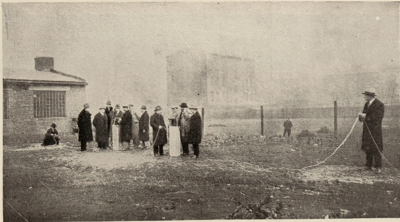
48. Kurs dla instalacji piorunochronów w Katowicach Pomiar oporu, podlegającego elektrolizie.
