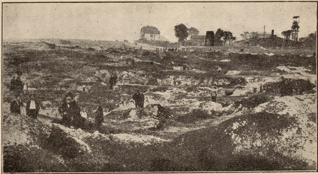
Bieda-szyby w Welnowcu po likwidacji.
