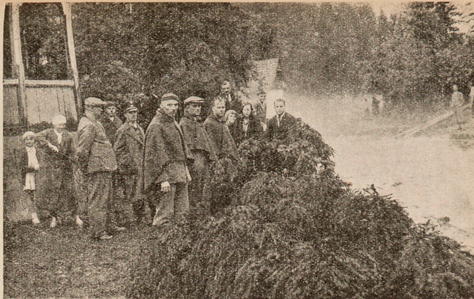
Potok Bystry tuż pod willą „Słazaczka“ w trzecim dniu powodzi, dnia 18. 7. 1934 r. Brzegi zostały wzmocnione drzewami, ściętymi na pobliskiej Antałówce przez nasze pogotowie powodziowe.
