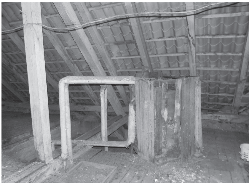
21c. Uszkodzony rezerwuar na zimną wodę pochodzący z okresu budowy szkoły
