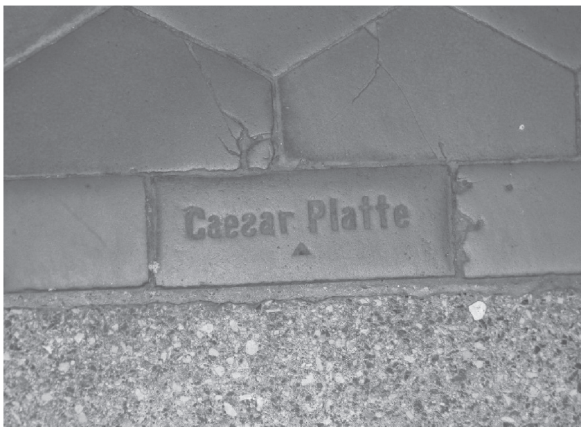
20. Oryginalna okładzina podłogi z nazwa typu kafelek „Cesar Platte”
