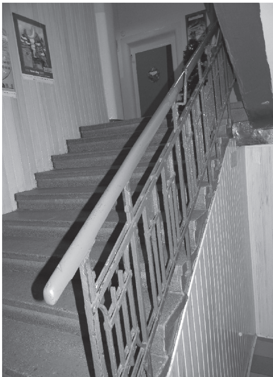
19. Modernistyczno- secesyjne poręcz z 1913 roku wewnątrz szkoły z widocznymi pałkami uniemożliwiającymi zjeżdżanie po nich
