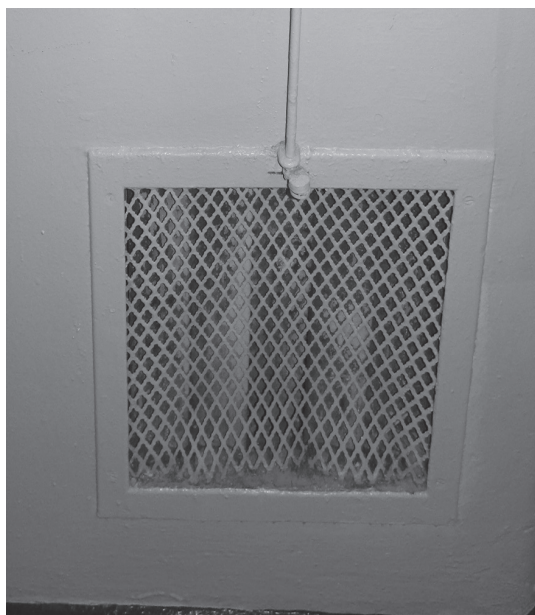
18. Zachowane fragmenty systemu nawiewu z 1913 roku
