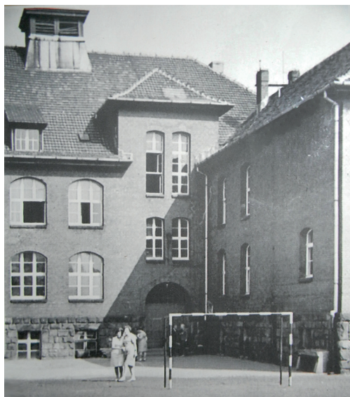
26. Zdjęcie z lat 70. przedstawiające elewację szkoły od strony podwórza z widoczną wieżyczką (zawierającą system wentylacyjny)
