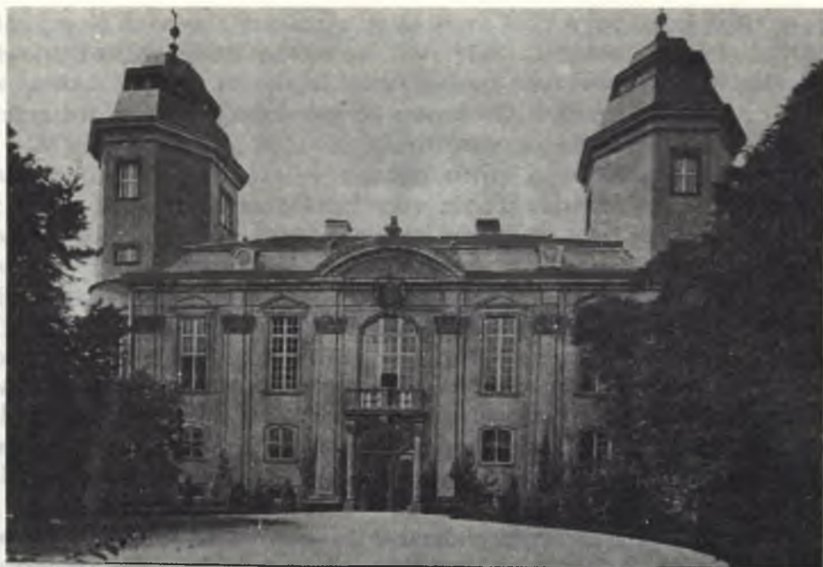
Vorderfront des Bibliotheksgebäudes.
