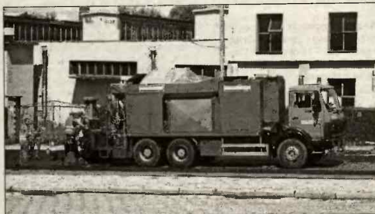
Prace przy nawierzchni na ul. Wyszyńskiego
