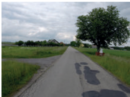
Droga 1096 S Celiny przed...
