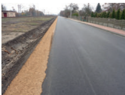
... i po przebudowie
