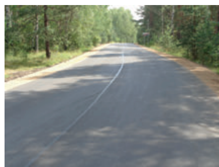
... i po przebudowie
