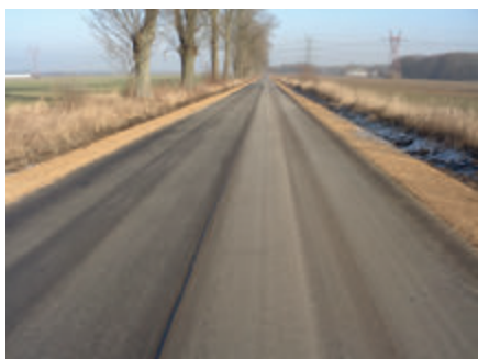
... i po przebudowie
