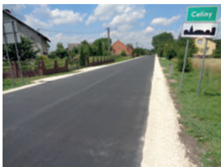
... i po przebudowie
