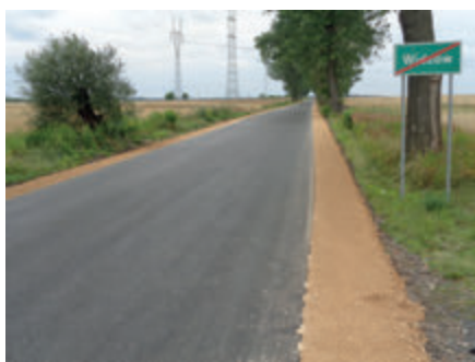
... i po przebudowie
