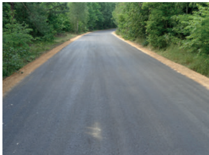
... i po przebudowie
