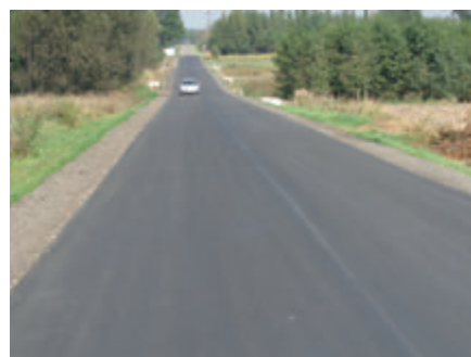
... i po przebudowie
