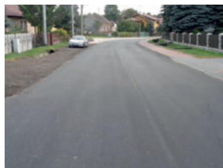
... i po przebudowie
