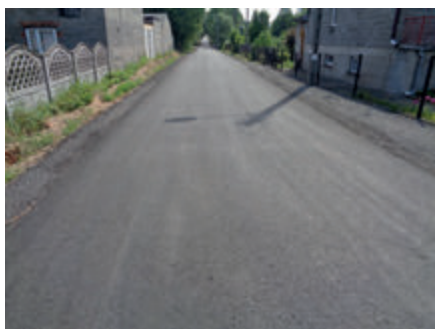
... i po przebudowie
