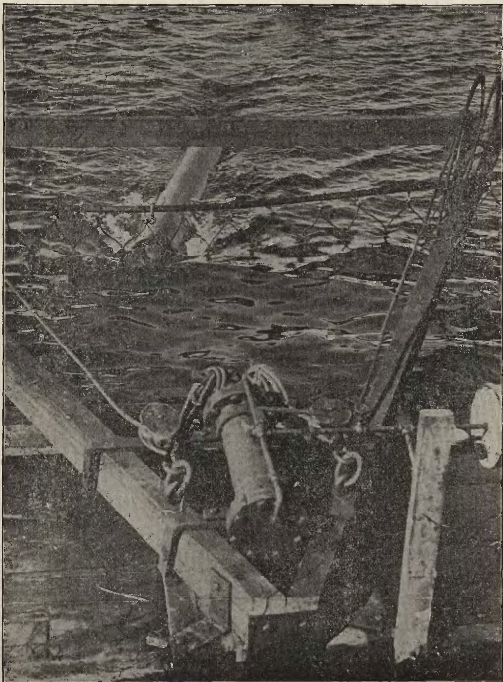
Nowy wynalazek, zabezpieczający przed torpedami. W oddaleniu 25 stóp od okrętu umieszcza się stalową sieć, w którą wplata się torpeda.
