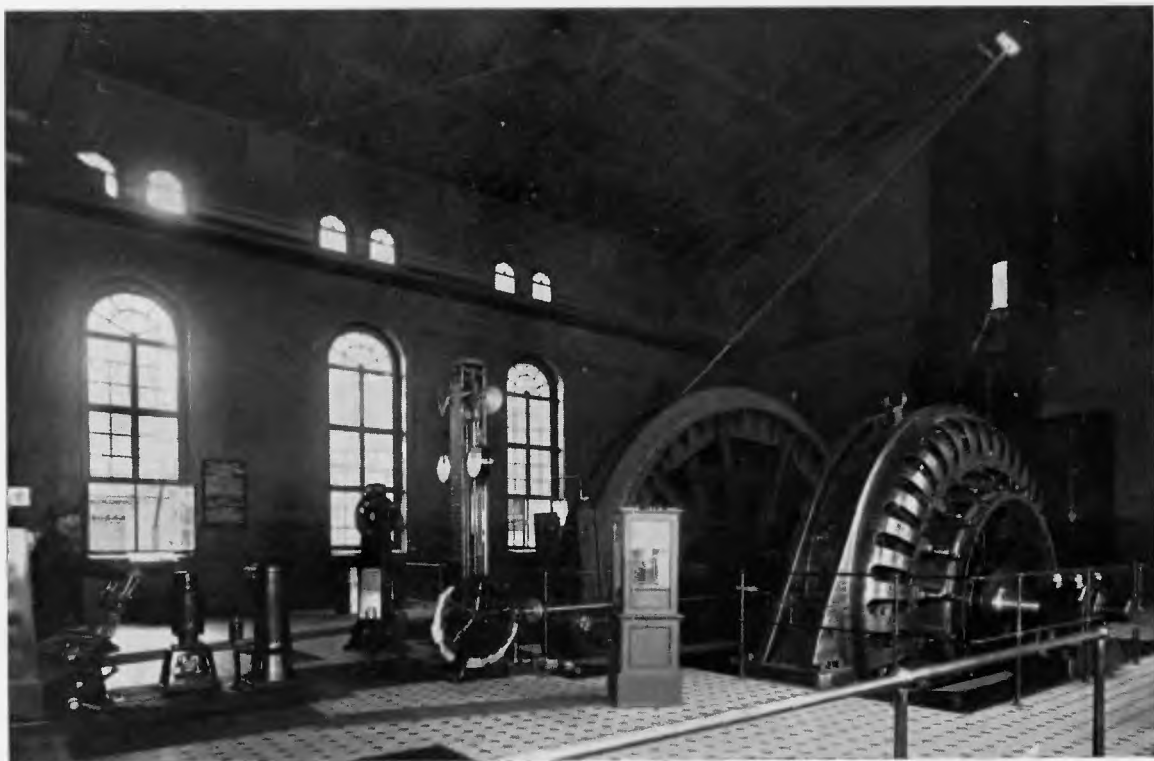
KOPALNIA „MICHAŁ”. ELEKTRYCZNA MASZYNA WYDOBYWCZA O MOCY 660 KW. PRZY SZYBIE KRYSTYN
