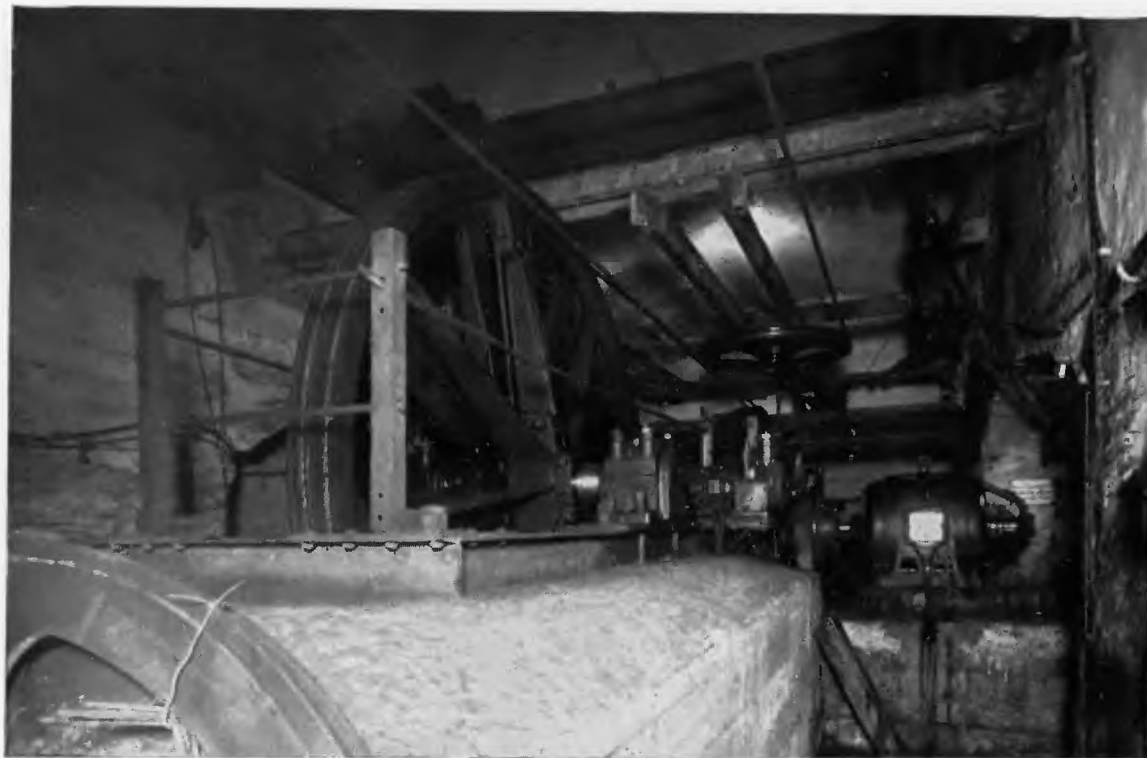
KOPALNIA „MICHAŁ”. MASZYNA NAPĘDOWA LINOCIĄGU NA UPADOWEJ KAROLINA
