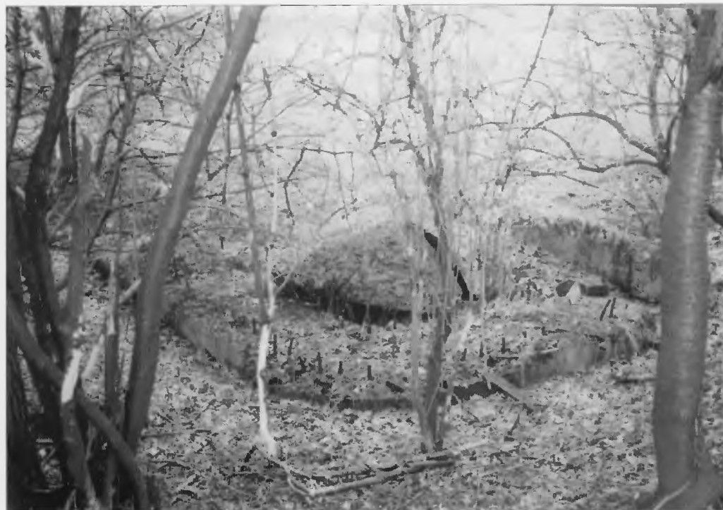
Fundament schronu nr 16. W środku stwardniała pryzma wymieszanego ręcznie betonu
