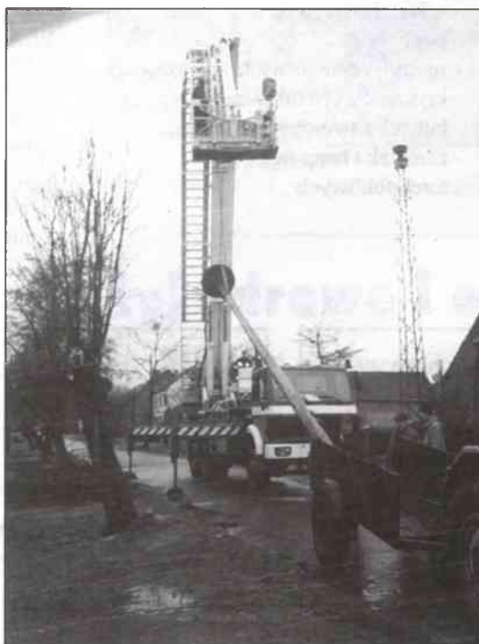
Podnoszenie nowego słupa z platformą.
