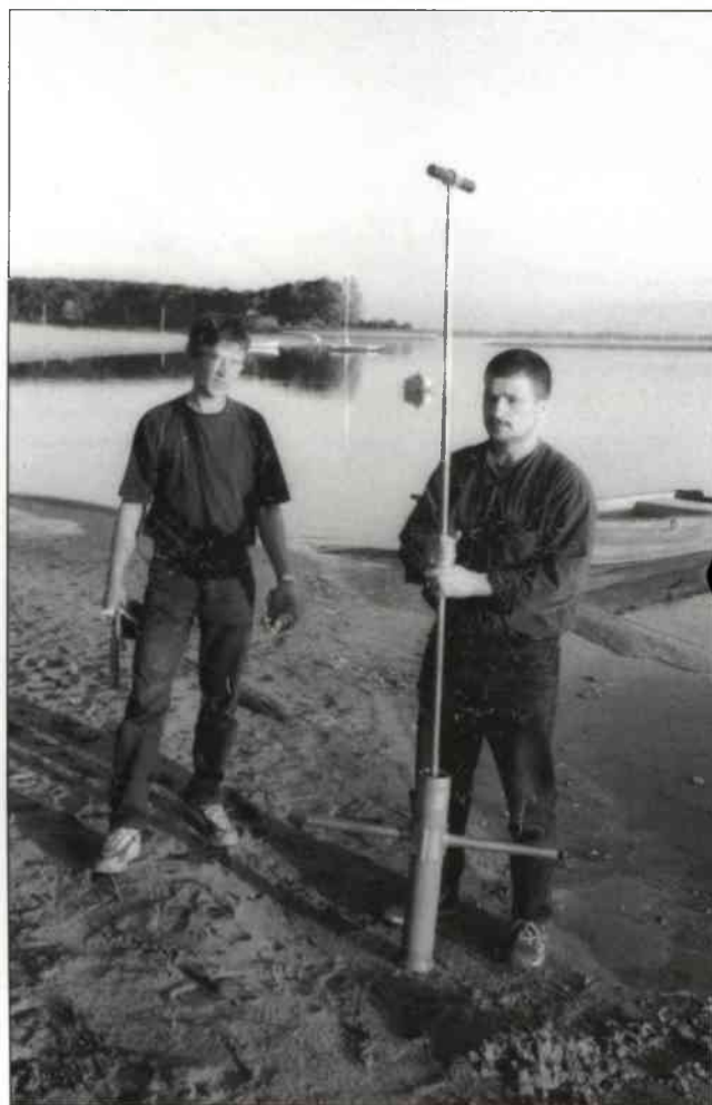
Jesienią ubiegłego roku przeprowadzono pierwsze próby ręcznego sondowania podłoża.
