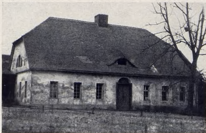
Abb. 9. Das alte Fischlereigebäude der Gleiwitzer Hütte. Vorderfront. Im Seitenriß (Abb. 8) das zweite von links. Einziges noch erhaltenes Gebäude der alten Anlage.
