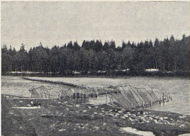
Ryc. 17. Wejście do ogródka »odjazki« widziane z przodu. A fence in the river established for catching spawners, called „odjazka“.
