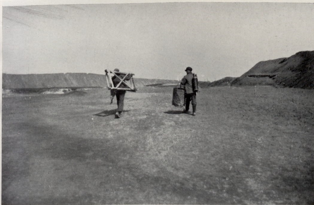
Abb. 2. Mit „Schachtgerüst“ und Förderkübel auf dem Wege zur Arbeit.
