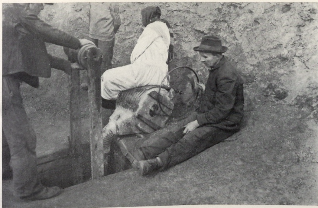
Abb. 1. An einem Notschacht.
