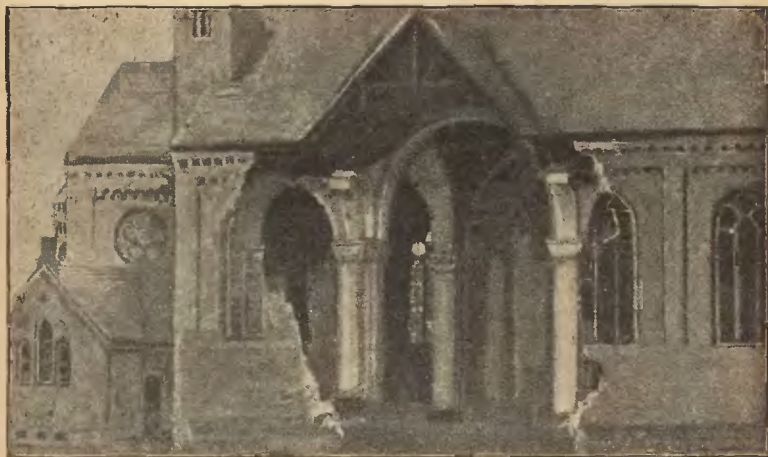
Częściowe zapadnięcie się kościoła w Inowrocławiu.
