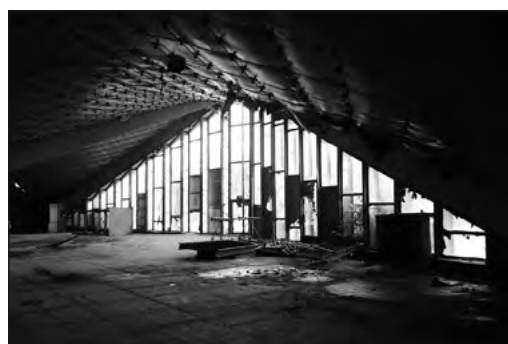
MTK Budynek nr 7
