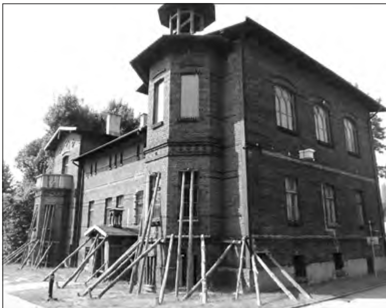
Budynek „Ostoi Pokoju” przed remontem (sierpień 2015 r.)
