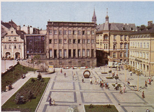
Po przebudowie w połowie lat 70. – choinki, których teraz tak żałuje część bielszczan, na zdjęciu są jeszcze malutkie. Za to doskonale widać kwadraty z czarnych płyt – po deszczu robiły się koszmarnie śliskie.
