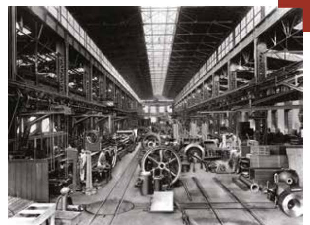
1910 – Warsztat mechaniczny, wybudowany w 1906 r., gdzie produkowano turbiny parowe.
