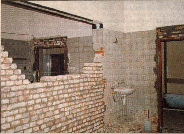
Tak wyglądała Klinika w czasie remontu. Wielkie sale chorych podzielono na trzyosobowe pokoje.
