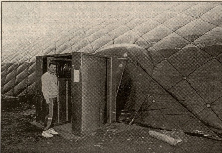
Jacek Widawski przed wejściem do nowej pneumatycznej hali.
