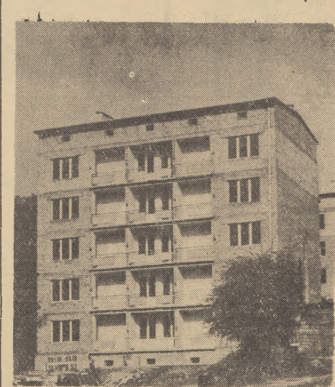
Nowe bloki Rybnickiej Spółdzielni Mieszkaniowej. Już wkrótce zamieszkają w nich lokatorzy.
