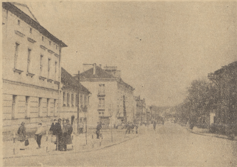
Fragment ulicy Dworcowej w Żorach. Na pierwszym planie zbudowany po wojnie piękny Dom Kultury, a za nim jeden z kilku bloków mieszkalnych FSK.
