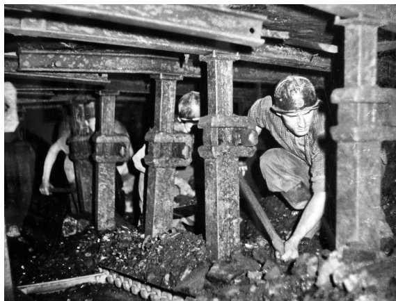
8. Załadunek urobku w ścianie ze stropnicami z szyn.
