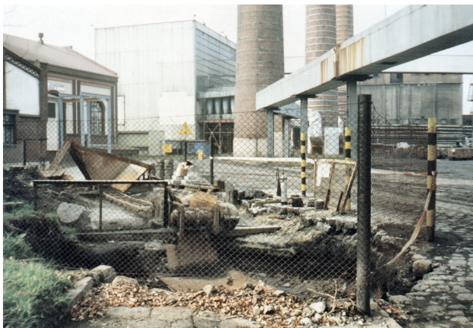
82. Zасыpywanie szybu „Leon I”. U góry z prawej strony przewód odprowadzający spaliny i parę z fluidalnej suszarni mulów do jednego z kominów.
