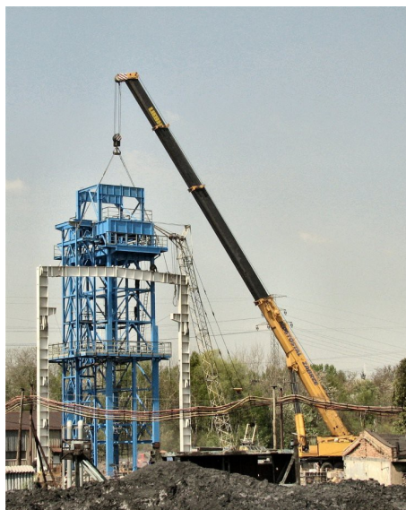
126. Montaż wieży i nadszybia.
