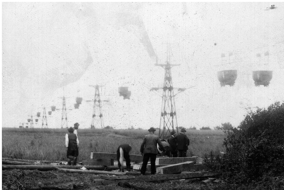
99. Zmodernizowana kolejka linowa z wozami kopalnianymi, pod którymi widać wyraźnie kółka.
