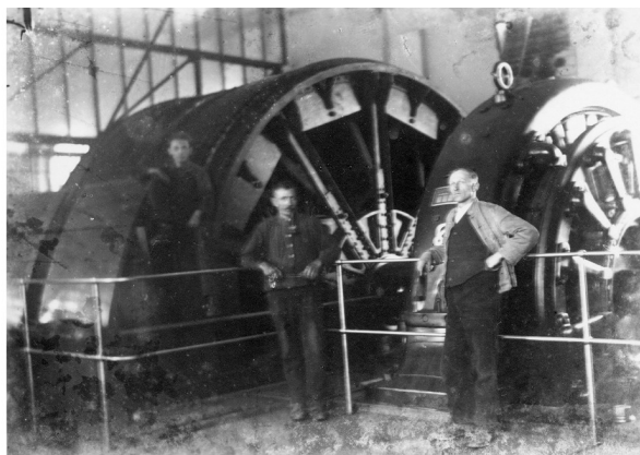
182. Elektryczna maszyna wyciągowa z 1914 roku.
