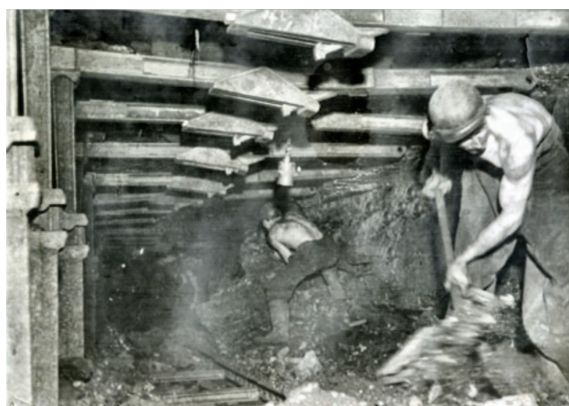
9. Załadunek urobku w ścianie z obudową stalową członową na jednej z górnośląskich kopalni.
