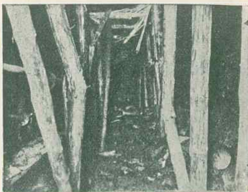
Rys. 11. Dowierzchnia po tąpnięciu
