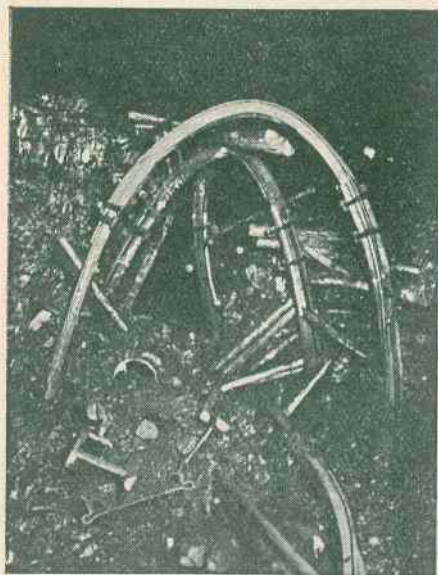
Rys. 29. Dowierzchnia w żelaznej obudowie pod mocnym stropem po tąpnięciu
