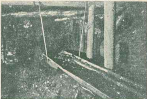
Rys. 27. Przecinka w przebudowie. W głębi przesunięty blok węgla
