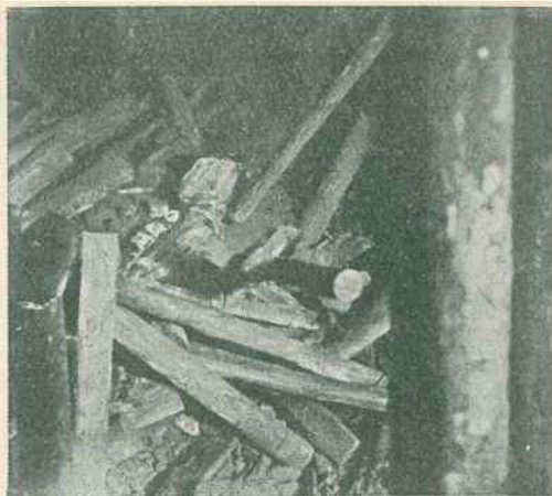
Rys. 28. Zdjęcie chodnika po tąpnięciu
