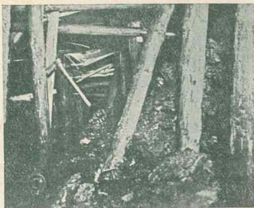
Rys. 16. Połamany budynek wskutek tąpnięcia
