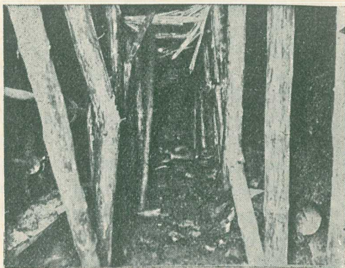
Rys. 11. Dowierzchnia po tąpnięciu
