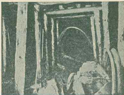
Rys. 31. Przebudowa w drzewie po tąpnięciu dowierzchni z żelazną obudową
