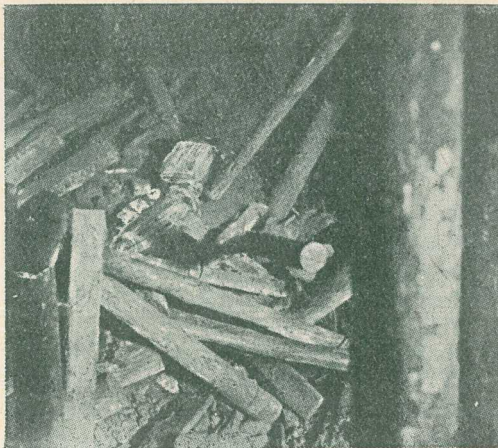
Rys. 28. Zdjęcie chodnika po tąpnięciu
