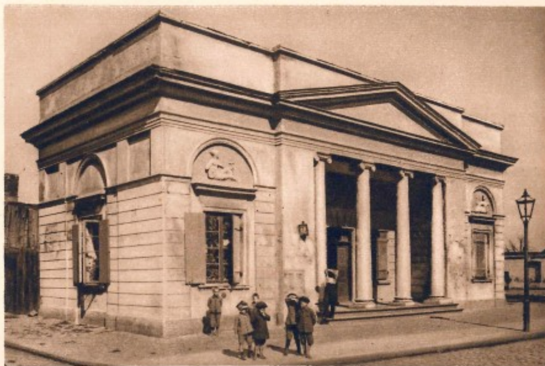
Dawna komora mostowa na Pradze.
