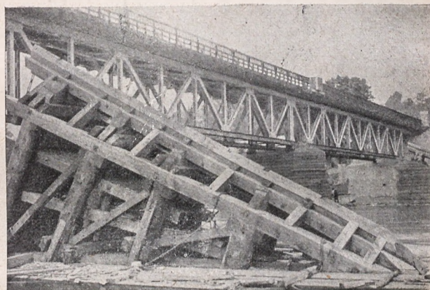
Rys. 12. Izbice i filary mostu.
