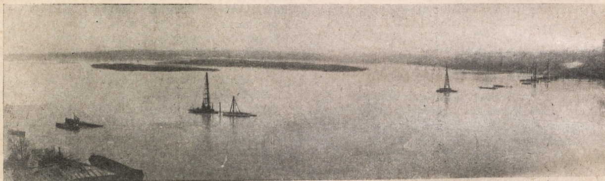
Rys. 1 Stan robót 20 grudnia 1915 r.
