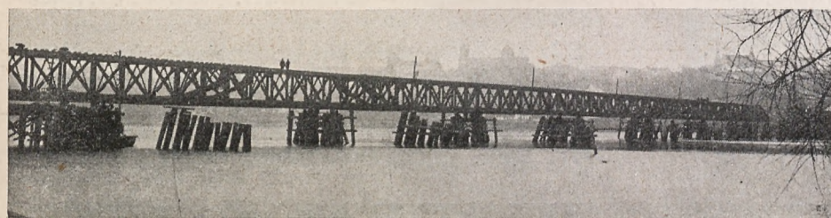
Rys. 10. Stan robót 10 maja 1916 r.
