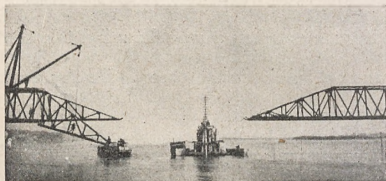
Rys. 9. Spotkanie obu części mostu nad filarem środkowym.
