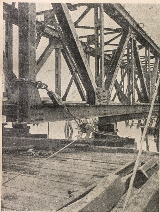
Rys. 5. Uchwycenie linami stalowymi części przesuwanych.
