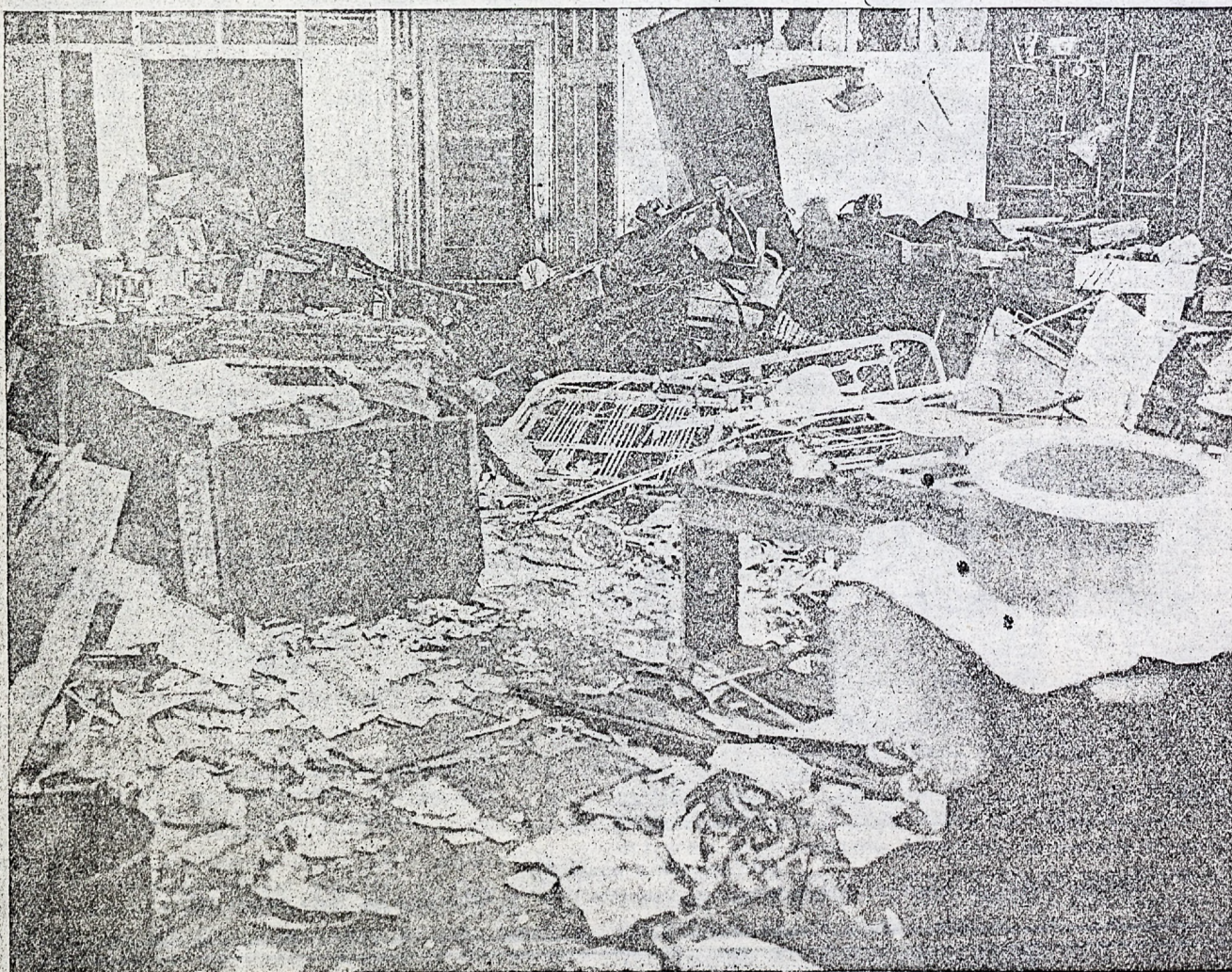
Zburzony sklep p. Czaplickiego w Katowicach, dnia 16 sierpnia 1920 r.
