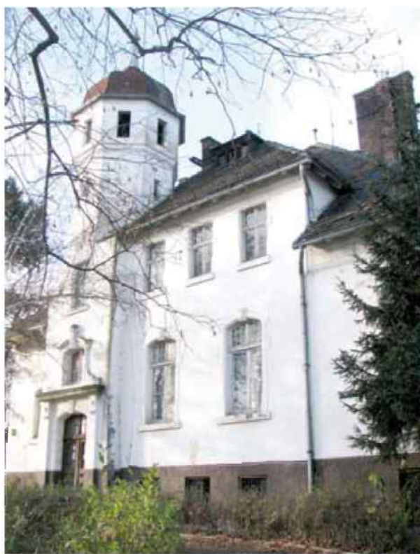
Niezabezpieczony budynek z każdym dniem niszczeje zmniejszając swoją wartość
