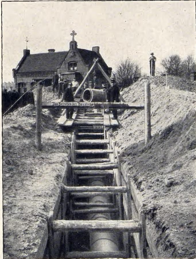
Tonrohrleitung 250 mm und Zementrohrkanal 600 mm l. W. bis zu einer Tiefe von 6,0 m für die Stadt Beuthen O.-S.
