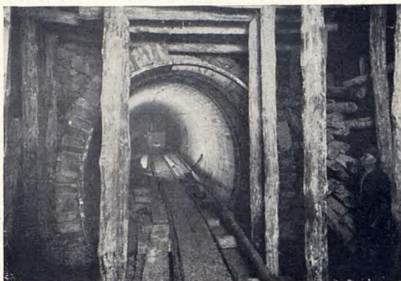
Nachgiebiger Ausbau in druckhaftem Gebirge mit Betonformsteinen und Druckholzeinlage
