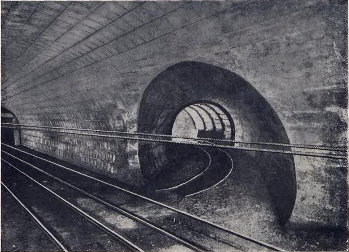
Bild 5 Betonformstein-Ausbau in einer Richtstrecke mit angesetzten Umbruchsörtern
