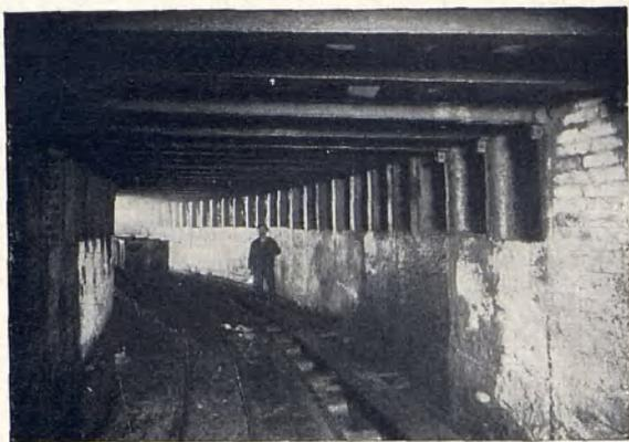
Strecken-Dauerausbau in sehr druckhaftem Gebirge. Stahlkappen, Betonpfähle, Rohrstampel mit Betonfüllung und Betonstoßmauer
