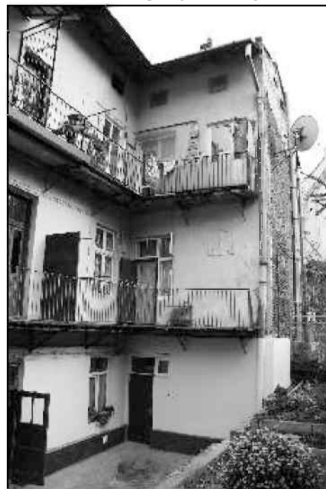
Kamienica przy ul. Św. Zofii 8a od podwórka (widok obecny) - są jeszcze widoczne fragmenty ogródka.
