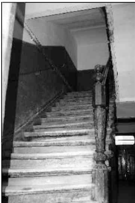
Fragment klatki schodowej przy ul. Św. Zofii 8a (widok obecny).
