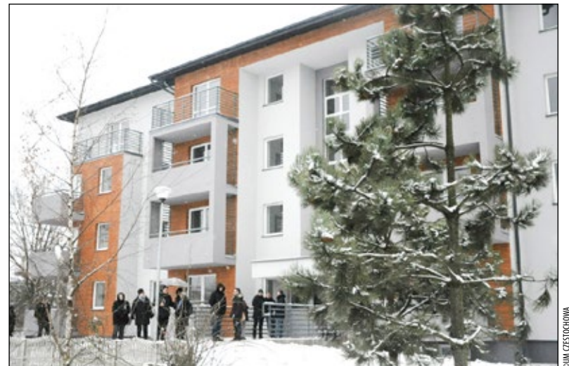
Do nowiutkiego budynku lokatorzy już się wprowadzają.
