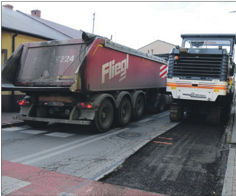
Prace trwały kilka tygodni na odcinku 760 m – mniej więcej od wysokości Gminnego Ośrodka Kultury.
