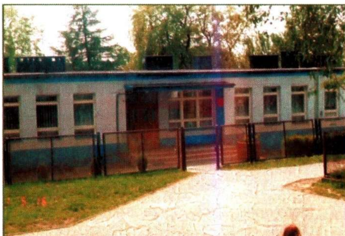
Przedszkole nr 2 (górnice) od strony wejścia
