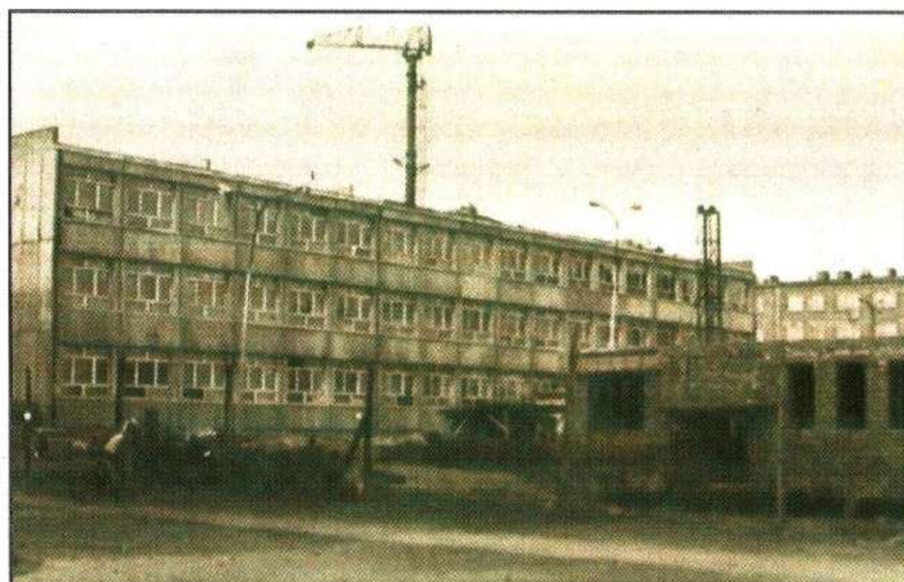
Budowa przedszkola górniczego
