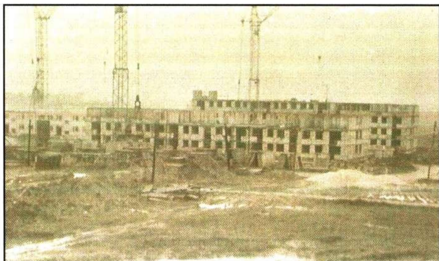
Prace budowlane przy osiedlu
