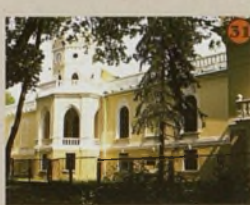
Pałac w Kłobucku - Zagórze
