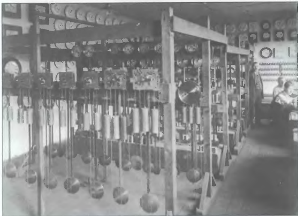
Stanowisko prób i regulacji mechanizmów wiszących zegarów
