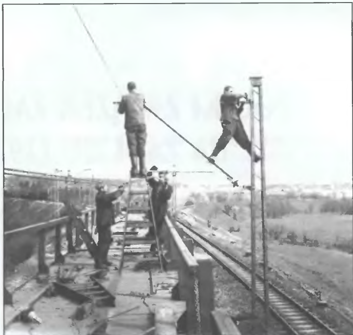
Kwiecień 1964 roku. Montaż sieci trakcyjnej, prowadzony w obrębie stacji PKP w Zebrzydowicach. Obok tor do Cieszyna, skręcający w prawo na wysoki nasyp. Zdjęcie autora
