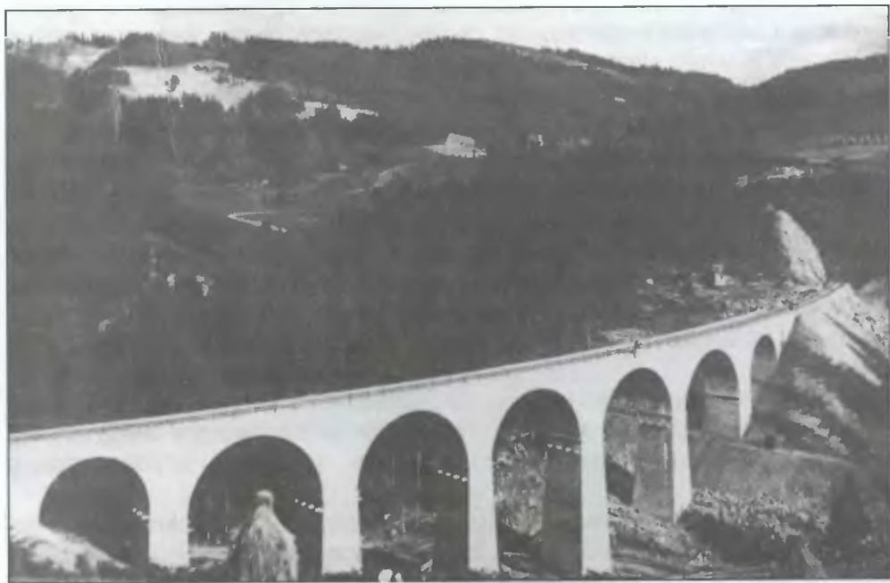
Wiadukt w Głębcach wkrótce po ukończeniu budowy. Ze zbiorów autora
