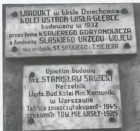
Umieszczone na filarze wiaduktu nad doliną Dziechcinę pamiątkowe tablice z nazwiskami projektantów oraz budowniczych obiektu. Zdjęcie autora
