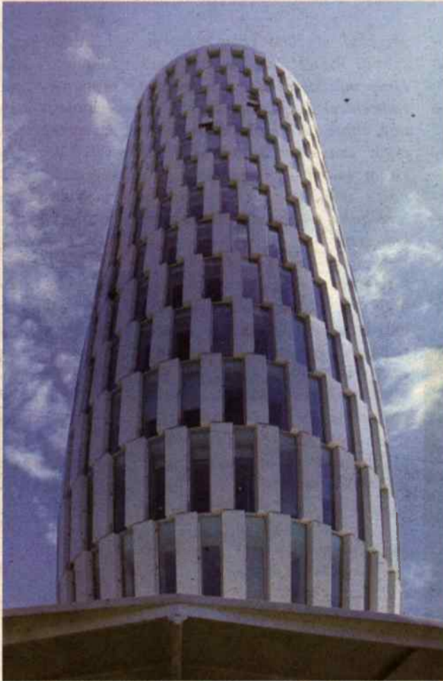
Oto jeden z budynków rządowych w Batumi.
