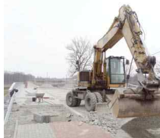
Na wybudowanym moście w Kałkowie trwają prace wykończeniowe
