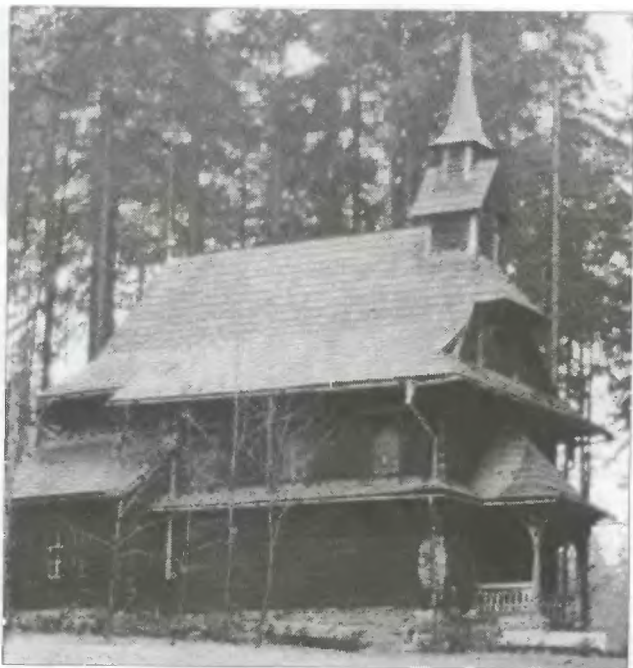
Kaplica z obrazami przeniesionymi z Bystrzycy. Na zdjęciu stan obecny. Fot. Dominik Dubiel
