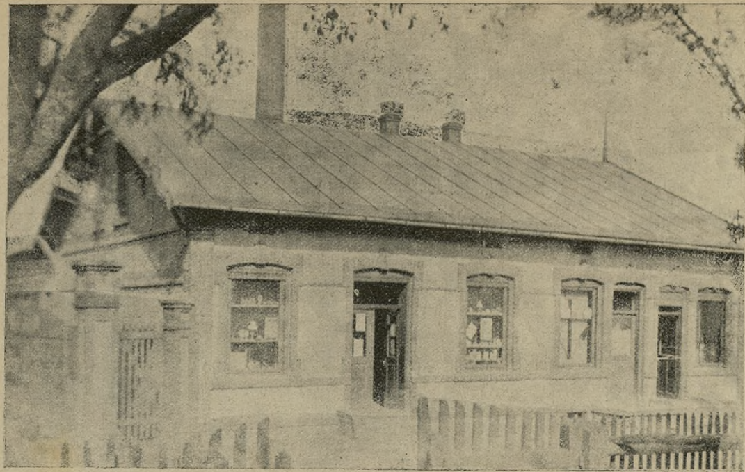
Centrala na Górzanach dom l. 49, w Stonawie.
