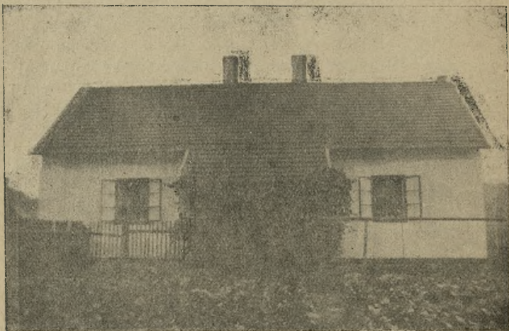
Dom mieszkalny l. 289, dzisiaj mieszczący rzeźnię, dawniej filia I. na Dolanach w Stonawie.
