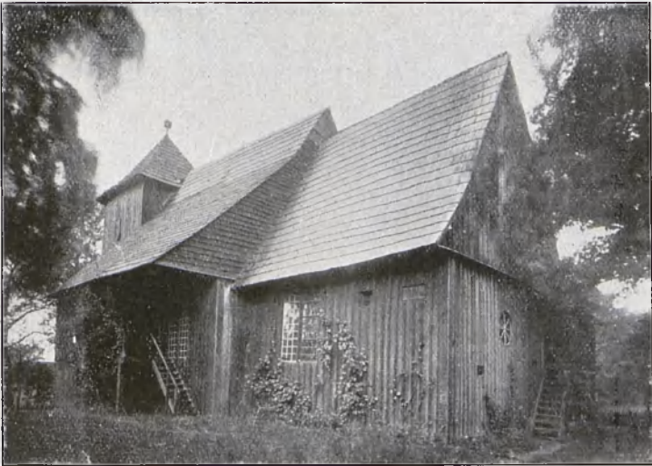
Nach einer photogr. Aufnahme vom Architekten Möller, Breslau.
