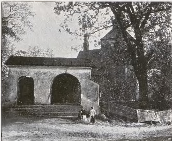
11. Holzkirche in Lisset (Kreis Rybnik), jetzt abgebrochen.
