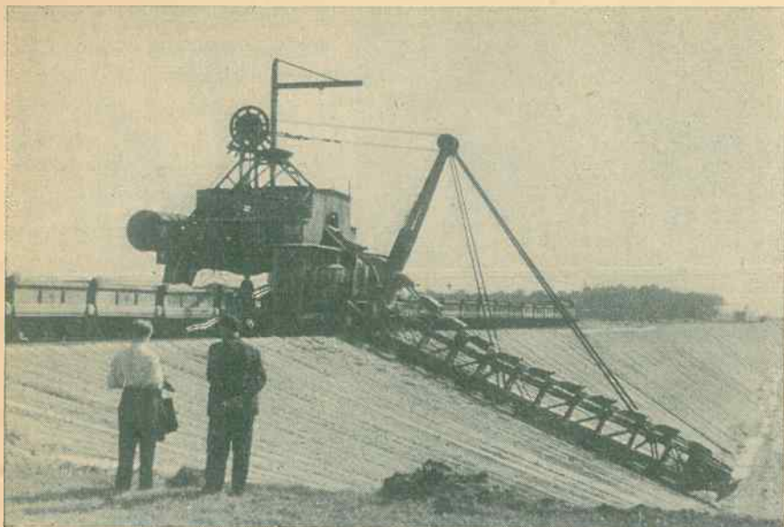
Rys. 28. Czerparka wiaderkowa podpoziomowa, ładująca wprost do wagonów
