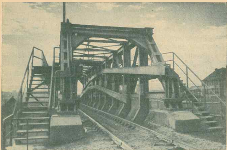
Rys. 33. Most wyladowczy nad zbiornikiem na piasek. Widoczne 2 szyny na prawym boku mostu służą do podnoszenia skrzyni wagonu z podwozia dla wysypania piasku
