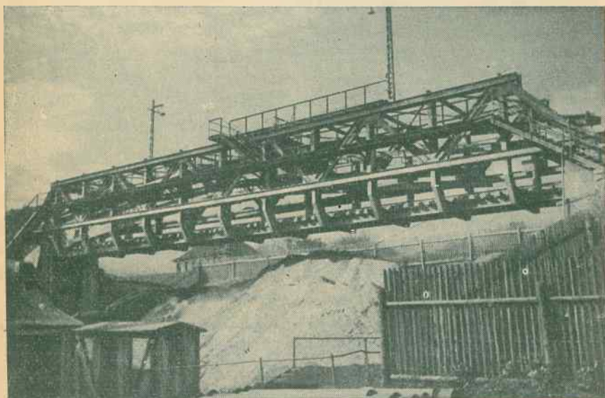
Rys. 34. Widok zewnętrzny mostu, przedstawionego na rys. 33, nad zbiornikiem na piasek umieszczonym w ziemi
