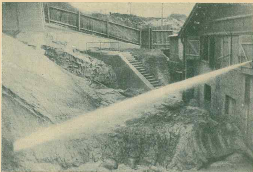
Rys. 37. Zmulanie piasku monitorem przedstawionym na rys. 36 w zbiorniku piasku pokazanym na rys. 34
