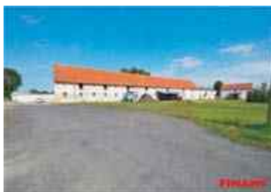
BAZA ROLNICZA Przylesie Dolne Działka 1ha, uzbrojenie energia woda kanalizacja CENA - 1 930 000zł
