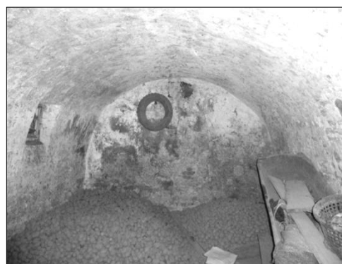
Piwnica w gospodarstwie Joachima Skowronka. Na ścianie widać zarysy zamurowanych otworów paleniskowych.
